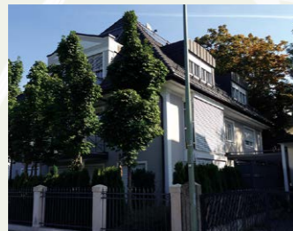
2. FERNPASSSTR. 26 (SENDLING) • Mehrfamilienhaus WNFL 520qm • Vier 2-5 Zi. Wohnungen
