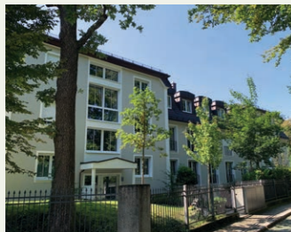
1. FÜLLSTR. 1-3 (HARLACHING) • Mehrfamilienhaus • 12 Wohnungen mit 1.480qm WNFL.
